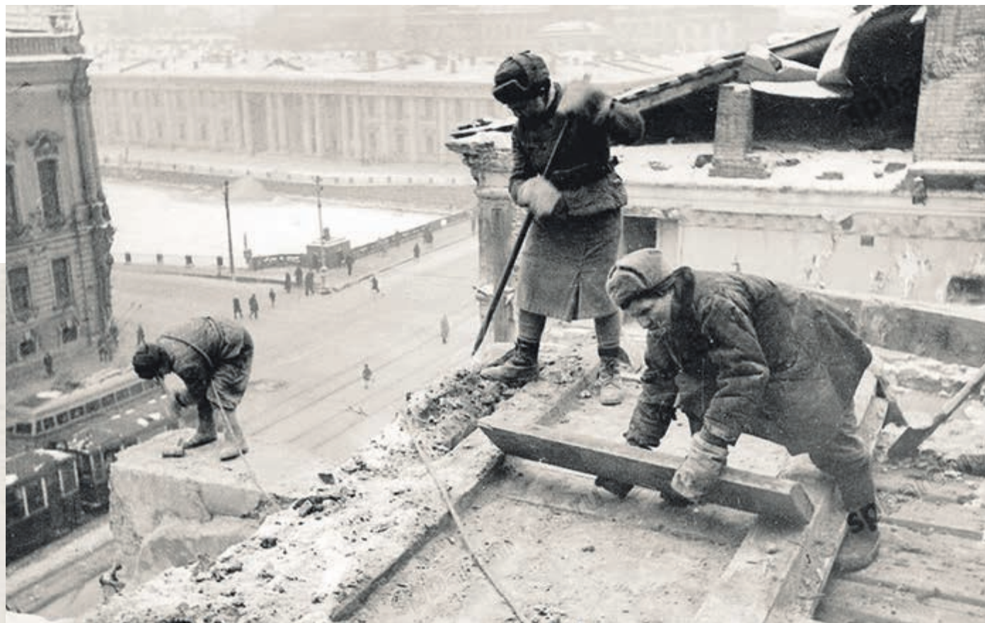
Бригада комсомолки Е. Ивановой, работающая в доме № 68 по Невскому проспекту, выполняет нормы на 127 процентов. Фото Д. Трахтенберга, «Ленинградская правда», 17 января 1945 года.
