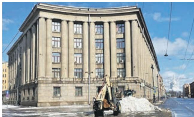
**СЕЙЧАС** фасады здания имеют многочисленные дефекты: осыпание и утраты элементов, сколы камня, трещины, деструкции... Сейчас проводятся конкурсные процедуры на определение подрядной организации, сообщили в Смольном. Это здание, подчеркнули в администрации
