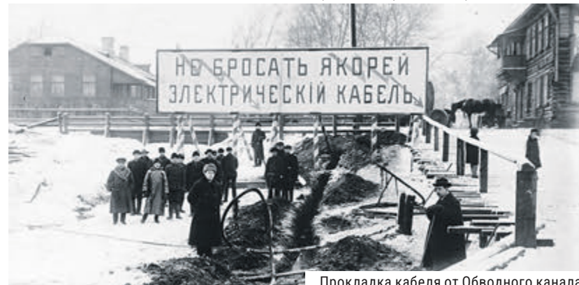
Прокладка кабеля от Обводного канала
