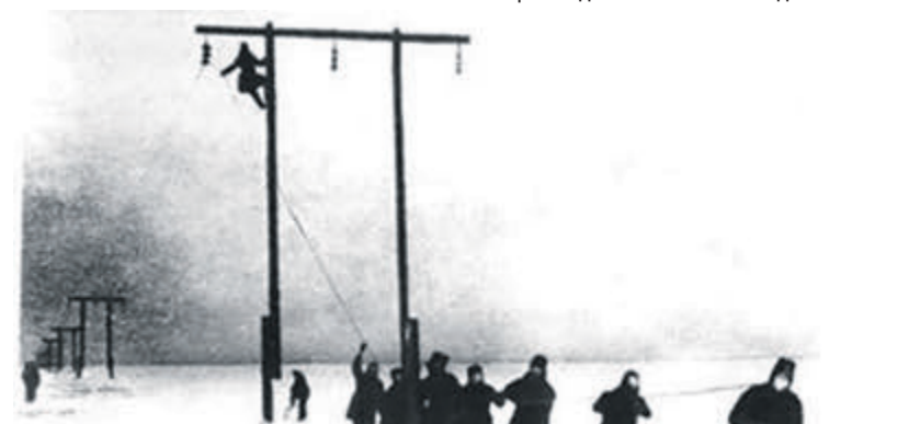
Прокладка ледовой высоковольтной линии. Ладожское озеро. 1942 год
